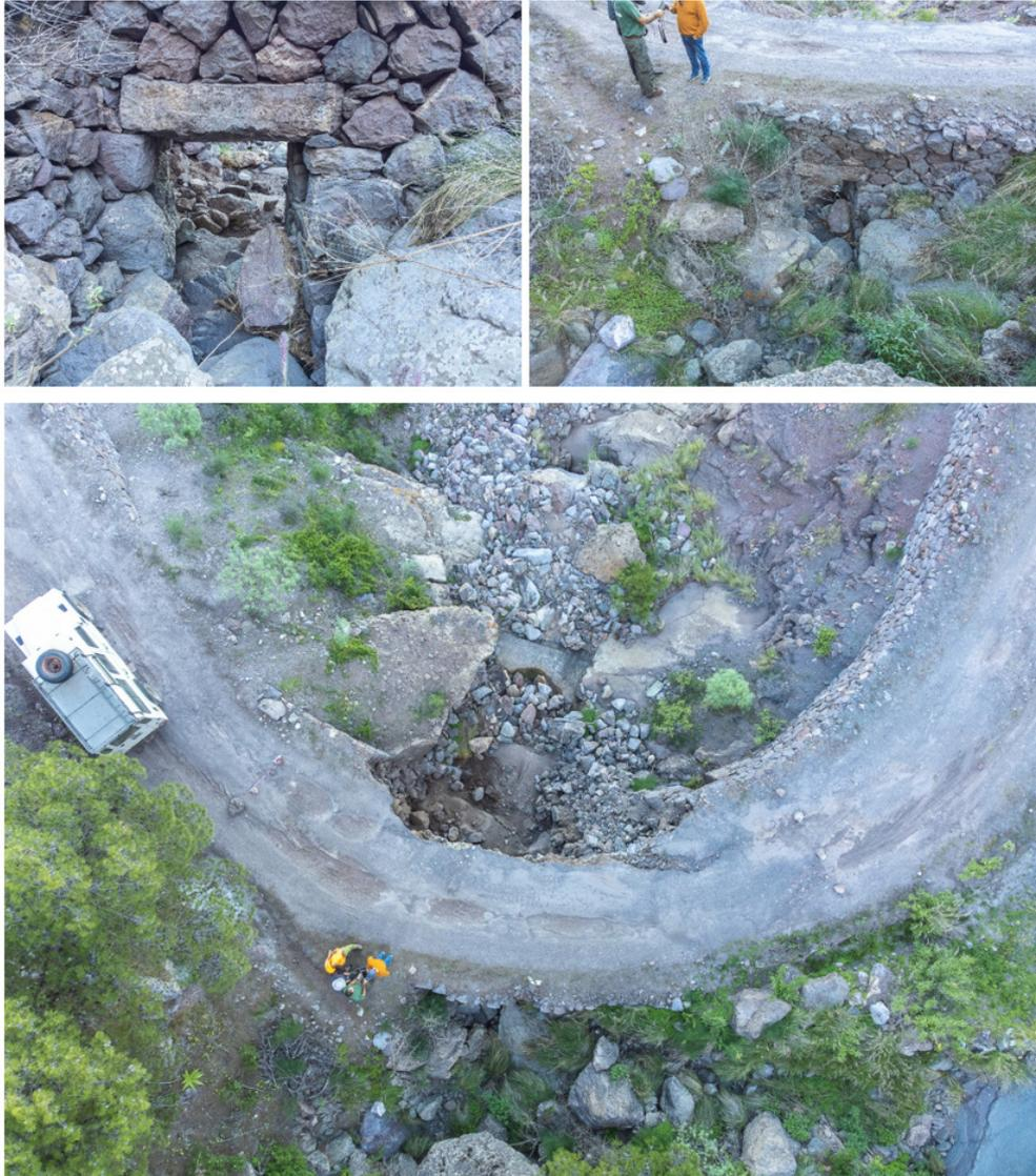
Una vez realizada la demolición y desmonte necesario para poder acometer los trabajos, se instalará la nueva obra de fábrica, compuesta por muros de mampostería hormigonada, placa alveolar, capa de compresión y relleno para restitución de la pista. El nuevo diseño de la obra de fábrica, implica la ejecución de muros de contención a ambos márgenes de la pista (aguas arriba y aguas abajo).
